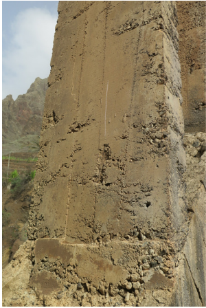
F38: M6: betão armado. Corrosão da armadura vertical
