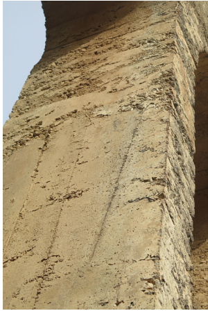
F39: M6: betão armado. Corrosão da armadura vertical
