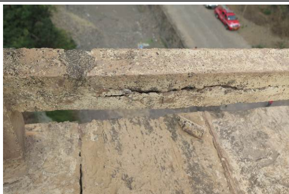
Figura 73 – Delaminação de betão no guarda corpos já com desprendimento de betão.
