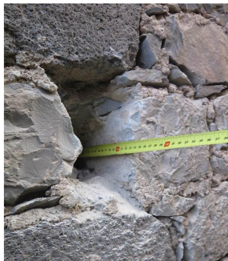
Figura 54 – Sondagem S1 com 23cm de profundidade em alvenaria de pedra.
