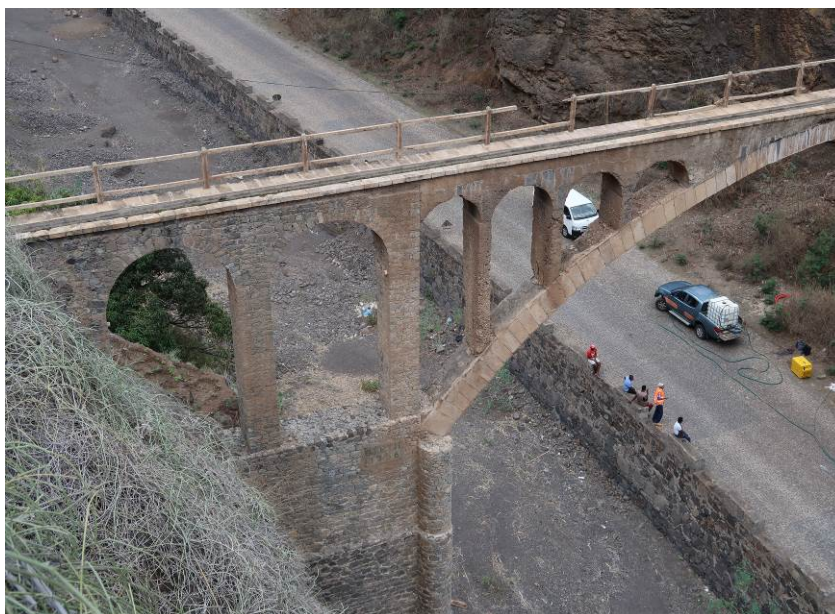
Figura 8 – Pilar do lado esquerdo (montante) e arranque do arco.
