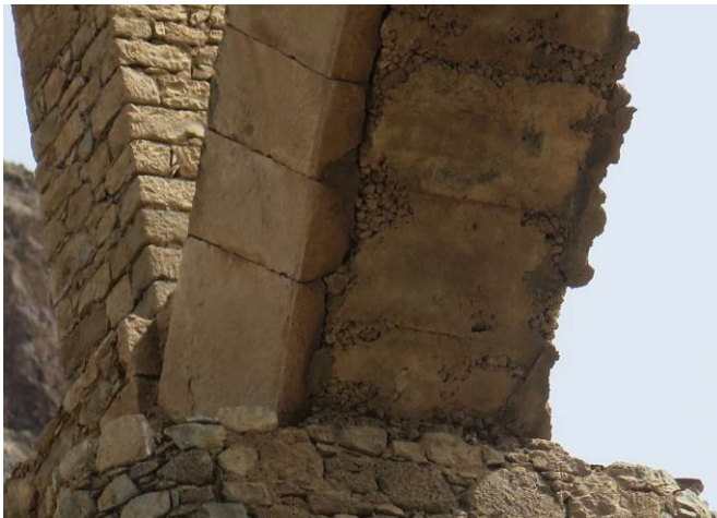
Figura 80 – Degradação do betão com perda de ligante no intradorso do Arco A1.
