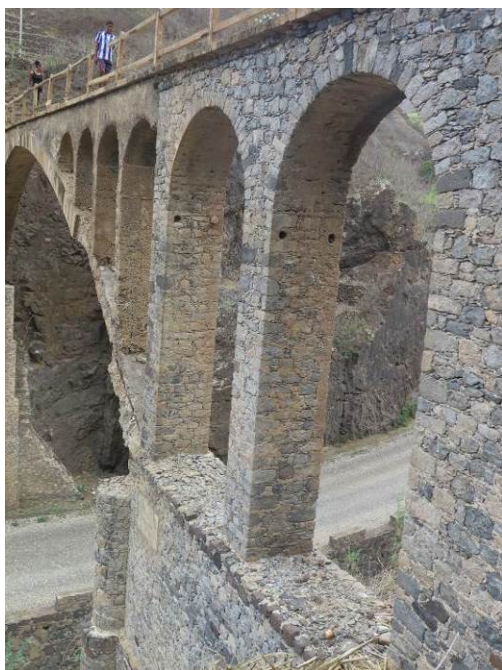
Figura 4 – Arcos de alvenaria sobre o encontro esquerdo.
