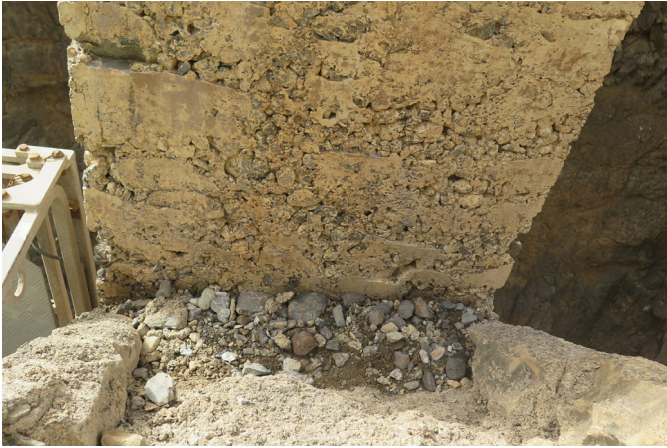
F35: Extradorso do arco junto a M6
