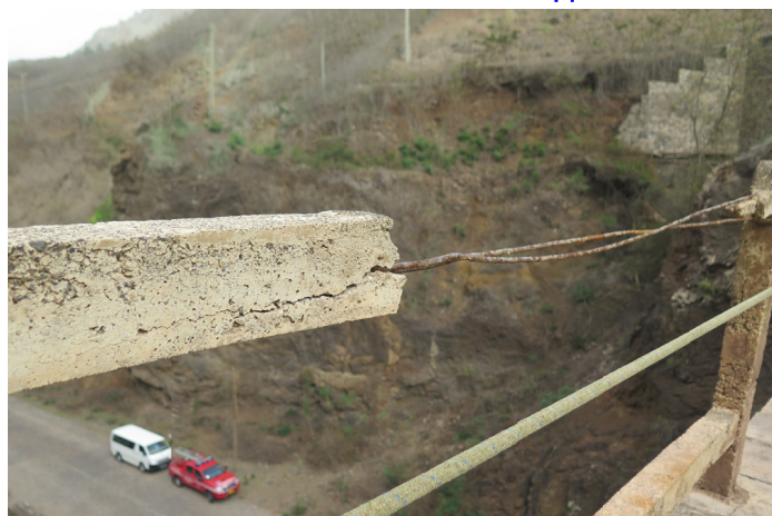
F2: Corrosão de armaduras e delaminação do betão
