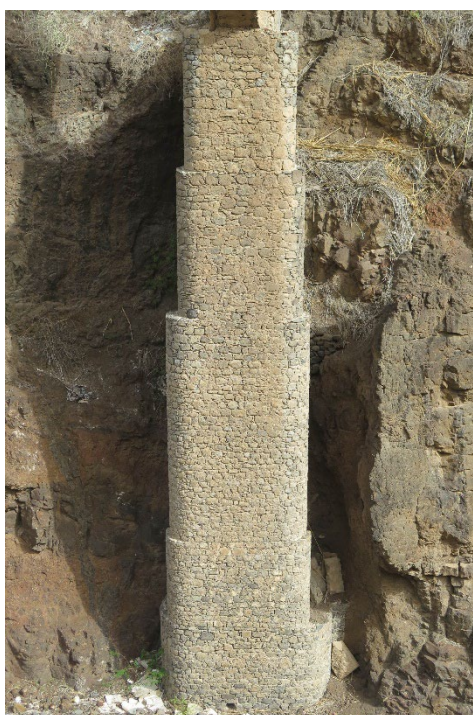
Figura 17 – Alvenaria de pedra em altura na variação da secção do pilar.
