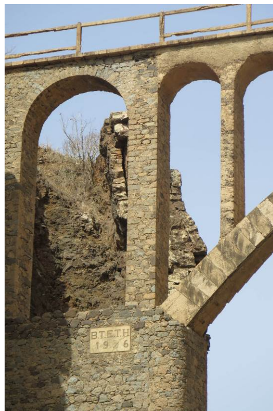
Figura 12 – Transição alvenaria/betão (jusante).
