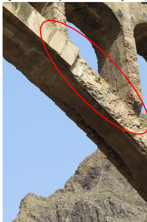
Figura 14 – Pormenor da zona lateral do arco com e sem forra lateral de pedras (jusante).
