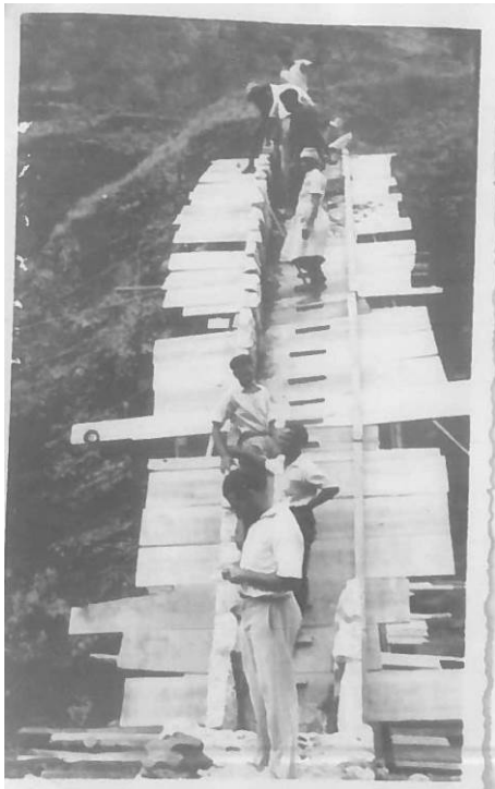
Figura 28 – Cimbra e assentamento das pedras laterais do arco.
