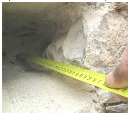
Figura 58 – Sondagem S3 com 34cm de profundidade em alvenaria de pedra.
