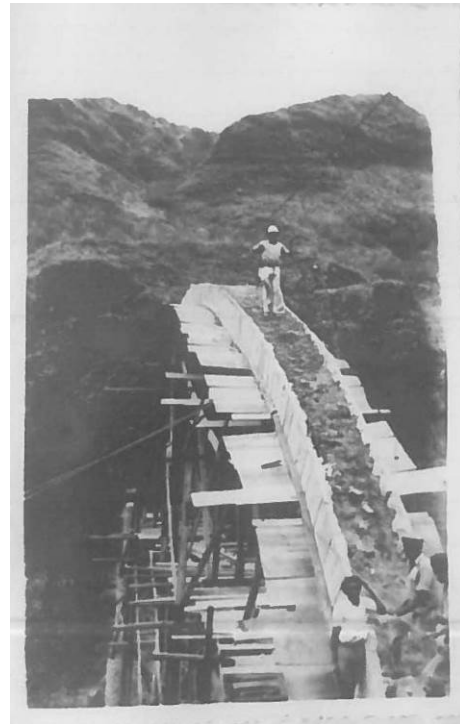
Figura 29 – Betonagem do arco sem se verificar o arranque de armaduras verticais para os montantes.
