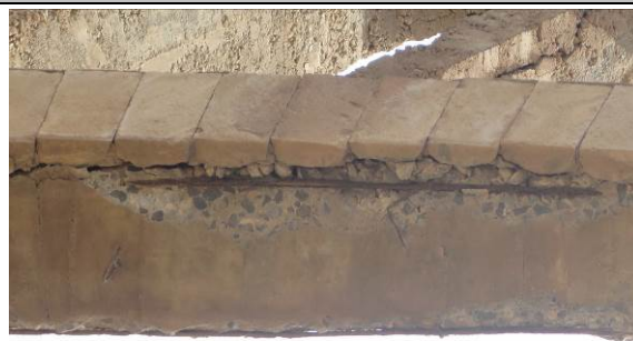
Figura 77 – Fissura entre o arco A1 e as pedras de forra com destacamento destas (face montante).
