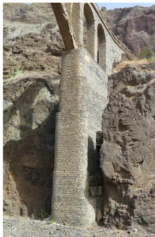
Figura 7 – Pilar e encontro do lado esquerdo (vista de jusante).
