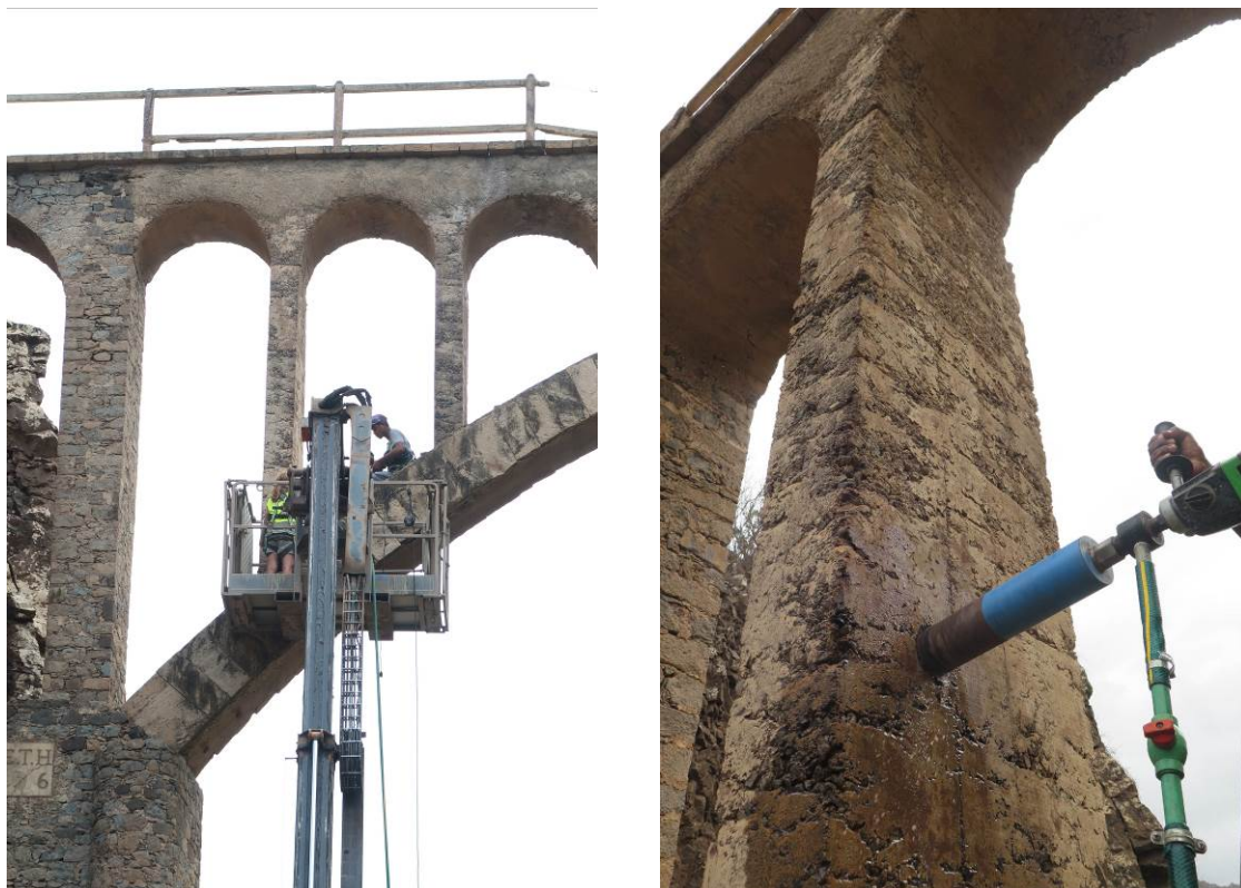
Figura 38 – Extração de carote no montante M6 de betão armado
