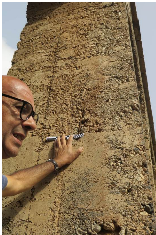
Figura 36 – Aspeto visual do betão do montante M6 cuja superfície não permite a execução de ensaio com esclerómetro.
