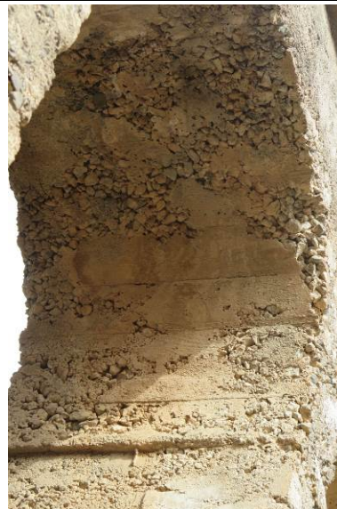
Figura 81 – Degradação do betão com perda de ligante no intradorso de arco de montante M3.
