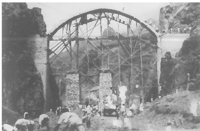
Figura 27 – Vista geral do cimbrio do arco com pilares de alvenaria de apoio à sua execução.
