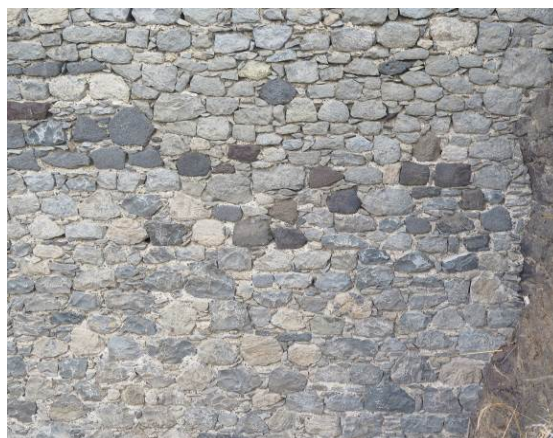
Figura 16 – Pormenor da alvenaria de pedra.
