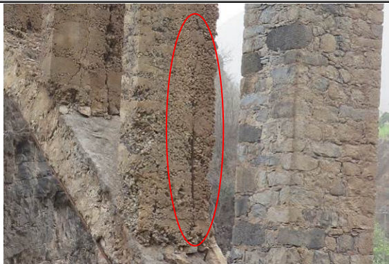
Figura 68 – Corrosão de armaduras e delaminação do betão no montante de betão M1
