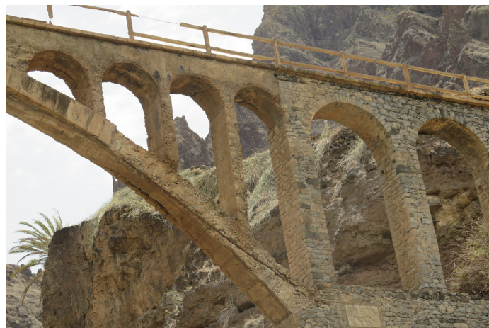
F8: Vista jusante da ligação entre estrutura de betão e estrutura de alvenaria
