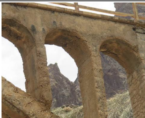
Figura 76 – Fissuração no topo do Montante M1 (face jusante).
