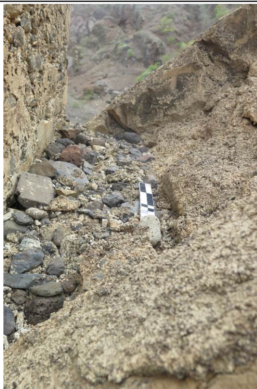
Figura 85 – Acumulação, aparentemente de inerte do betão, junto ao arranque do montante M6.
