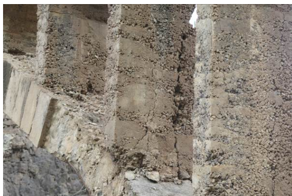
Figura 19 – Aspetto geral do betão nos montantes.
